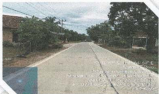
Peningkatan Jalan Ruas Jalan Kalidadi - Sendang Mulyo (R.244) Lanjutan Kec. Kalirejo sepanjang 1,185 Km.
